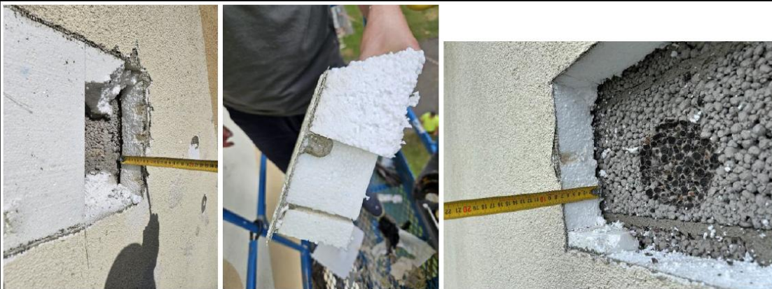
Foto Nr. 127, 128, 129 Ārsiena siltināta ar EPS tipa putupolistirolu 70mm.
