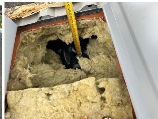
Foto Nr. 234 Atsegums Nr.10. Jumts siltināts ar 2x100mm akmens vati.
