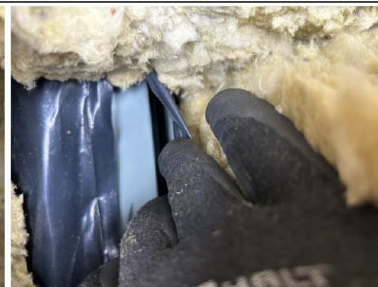
Foto Nr. 232 Atsegums Nr.9. Uz profilklāja ūdens klātbūtne nav konstatēta.
