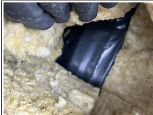
Foto Nr. 231 Atsegums Nr.9. Virs nesošā profilklāja ieklāta polietilēna tvaika izolācija.
