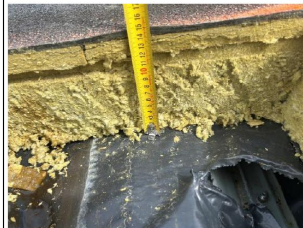
Foto Nr. 163 Atsegums Nr.3. Kopējais siltinājuma biezums 140mm.
